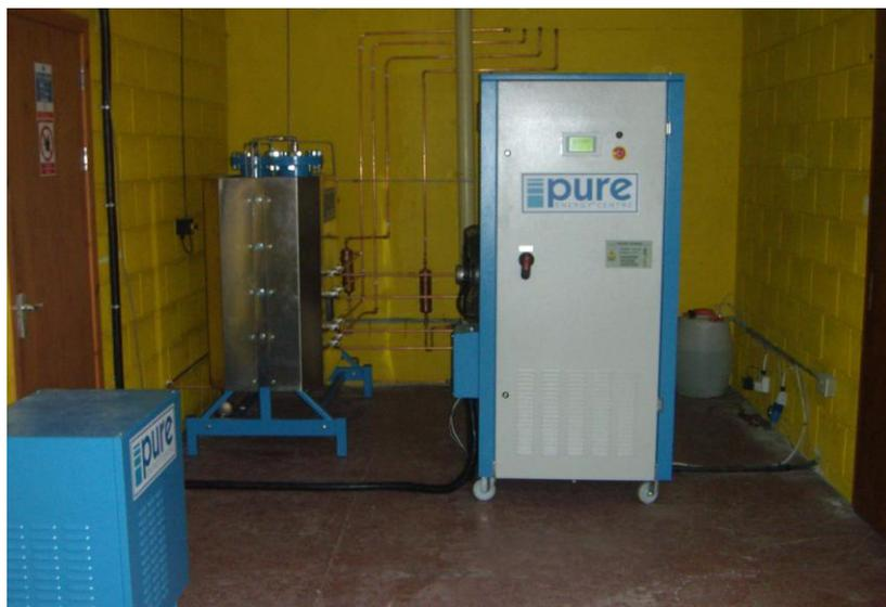
Figure 2. Pure<sup>®</sup> Hydrogen production system
